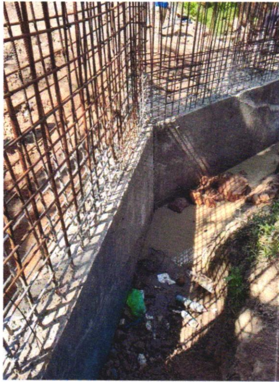
Estruturas Inferiores Concretadas para Seguimento da Super
