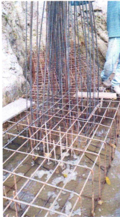
Detalhe da Armação de Pilares e Bases
