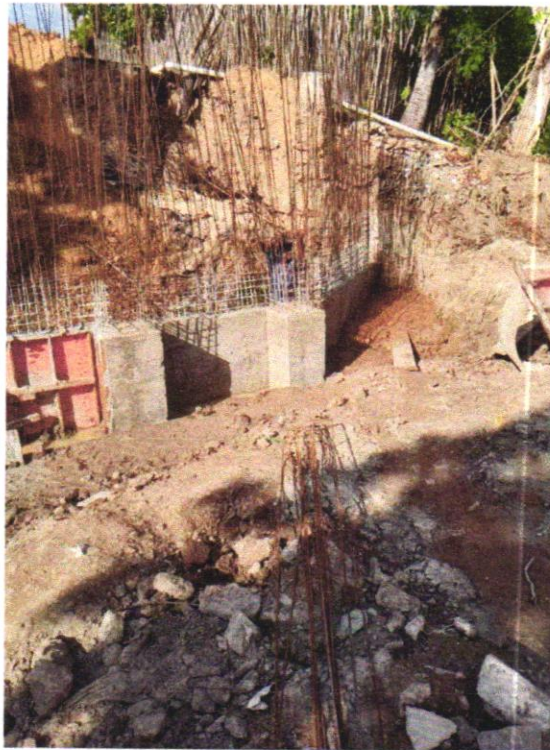
Estruturas Inferiores Concretadas para Seguimento da Super
