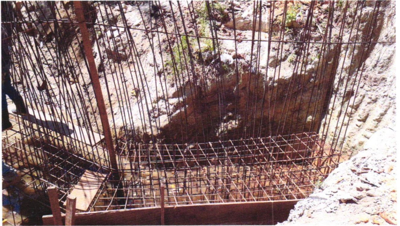
Detalhe da Aarmação das Alas e Base
