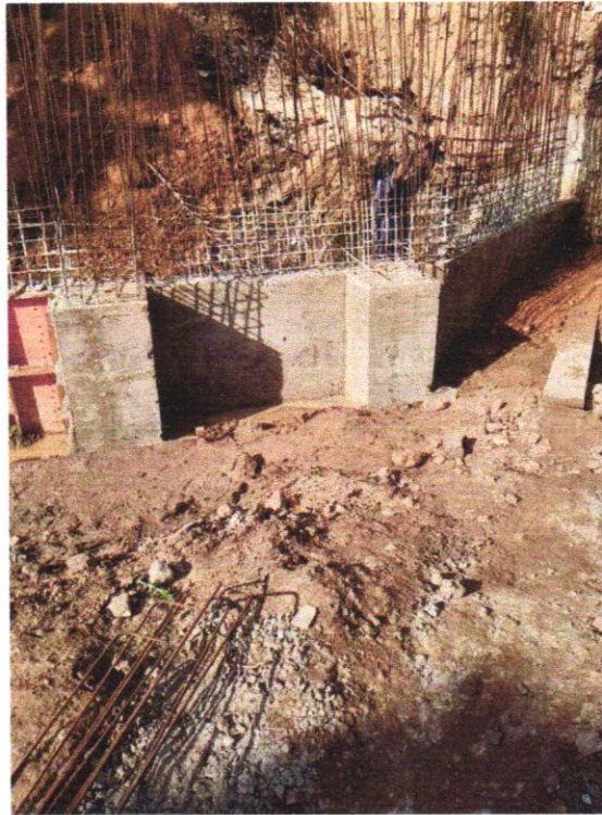
Contenção e Alas Concretadas
