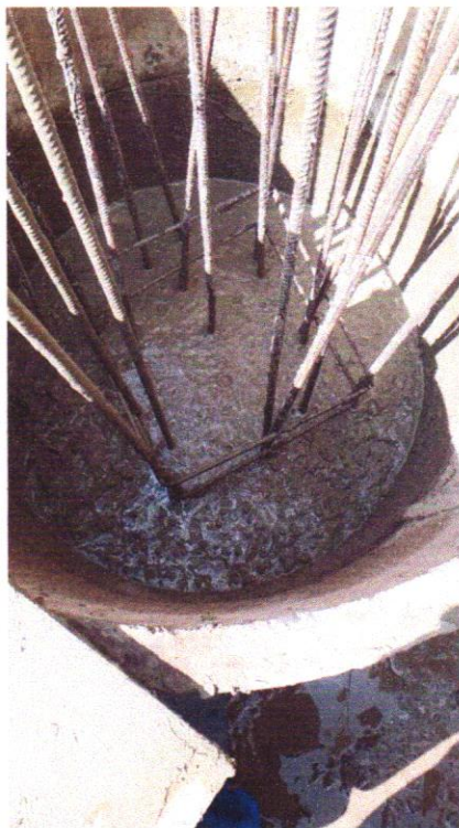
Concretagem de Ancoramento de Estrutura
