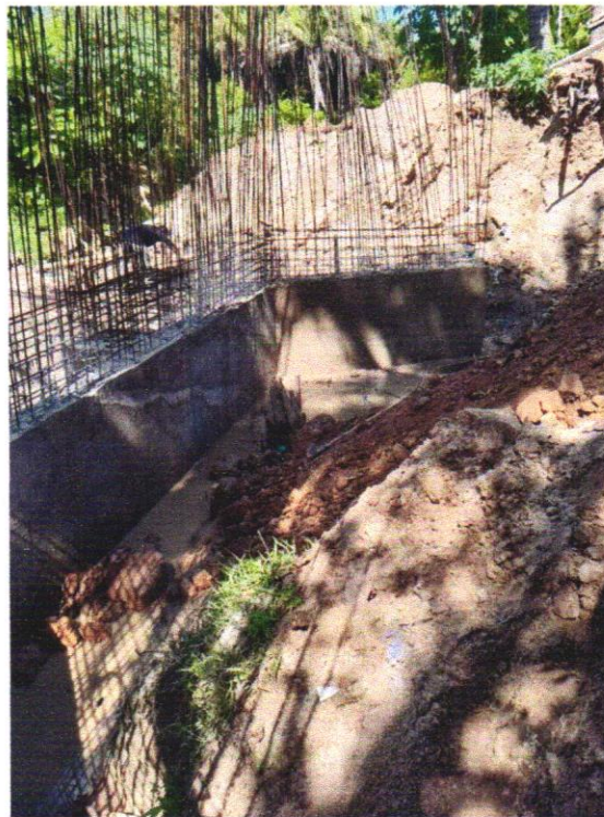
Contenção e Alas Concretadas
