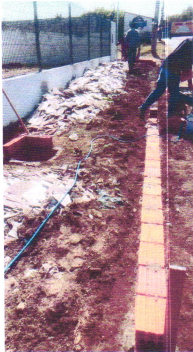
Foto 05: Calçada sendo executada
