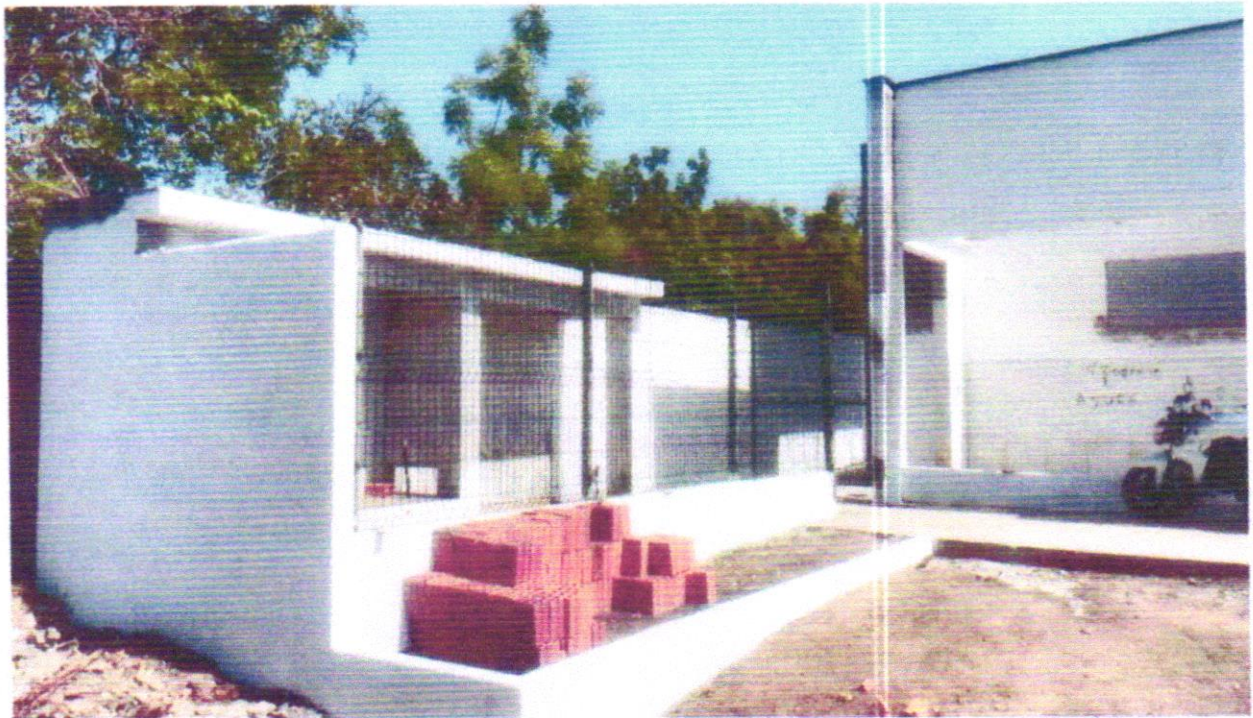
Foto 01: Casa do gás.
